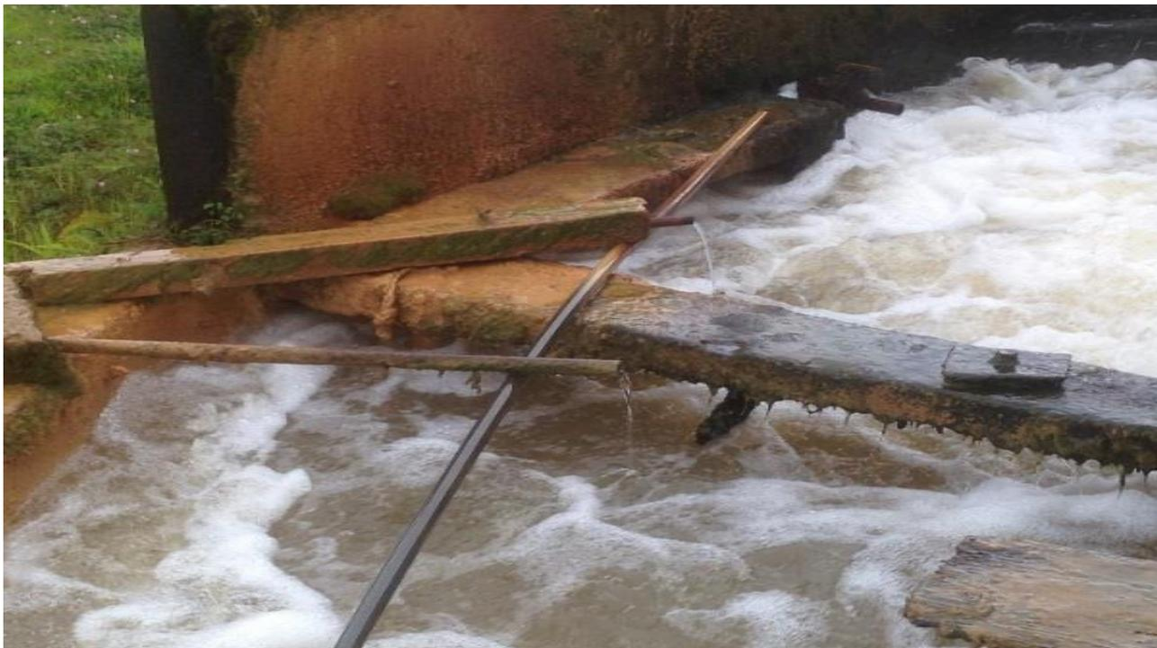
**Figure 3 : injection de SA et Purifloc**
