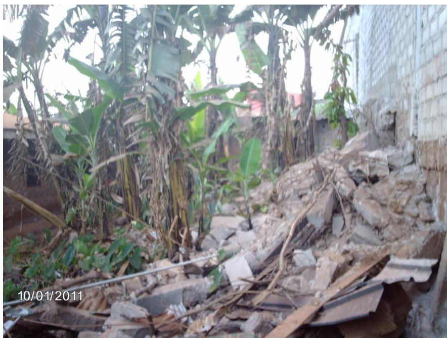
Photo 3 : Débris de la clôture de la SCS dans un domicile après l'explosion d'une chaudière en octobre 2010
