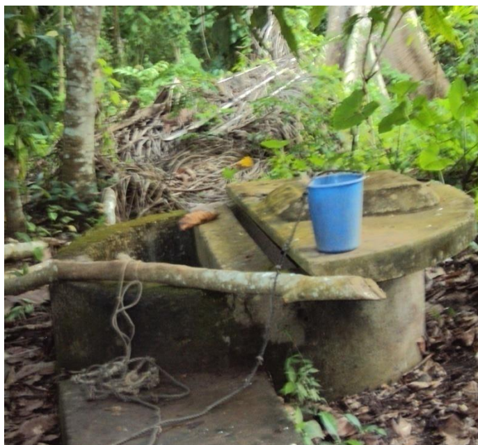
Photo 3 : Mauvais entretien d'un forage
