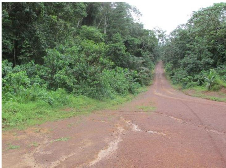
**Photo 2: Etat de dégradation de la route sous l'effet de l'érosion (eaux de ruissèlement)**
